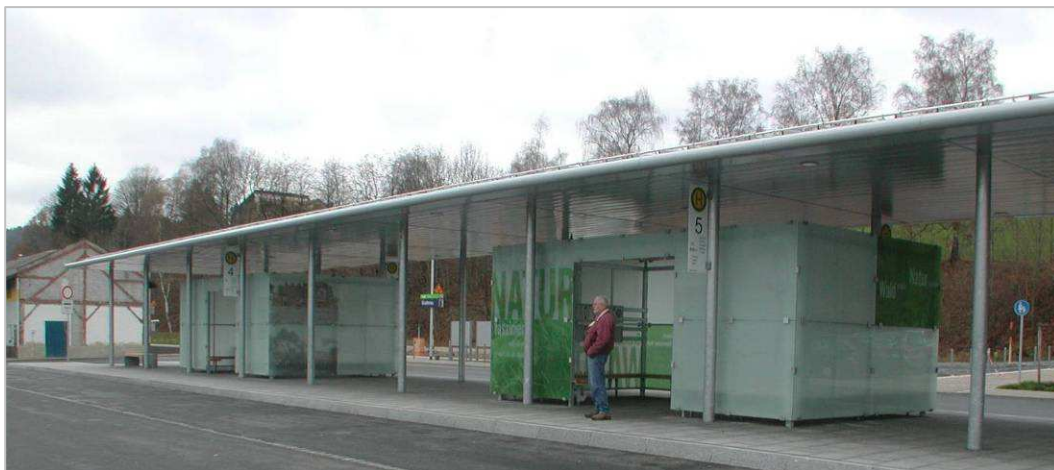
Foto: Der neue Zentrale Omnibus Bahnhof in Grafenau (ZOB)
